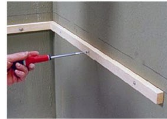
Installation des tasseaux
