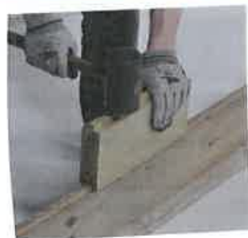
A l'aide d'un maillet, frappez sur la cale en bois pour emboîter à fond le madrier.
