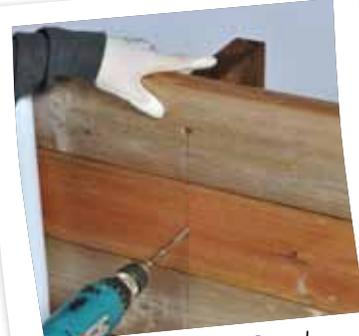
Fixez les renforts et les consoles avec les vis de 6 x 90 (1 vis par madrier)
