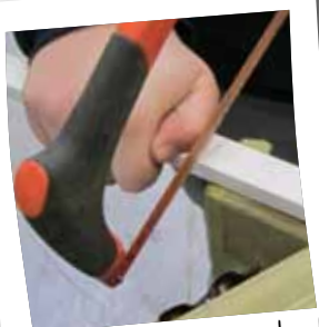
... et découpe de la baguette de liner
