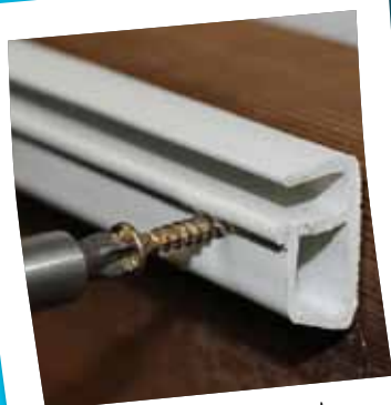
Fixation de la baguette de liner.
