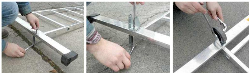
Montez la structure de l'échafaudage en position couchée.
