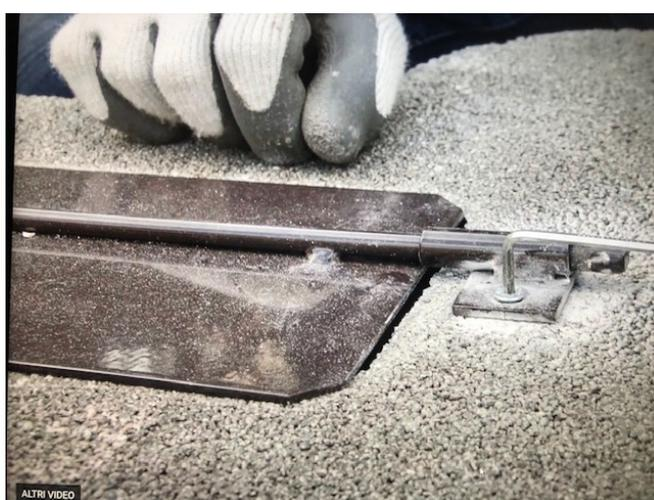
Posez l'élément sous-hotte en faisant attention à laisser l'ouverture pour la sortie de la fumée et fixez le registre comme sur la photo.
