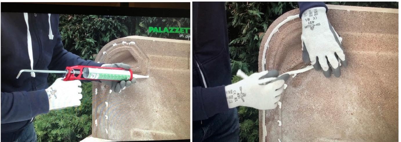
Appliquez quelques points de colle Easyfix le long de la rainure et y introduire le joint.
