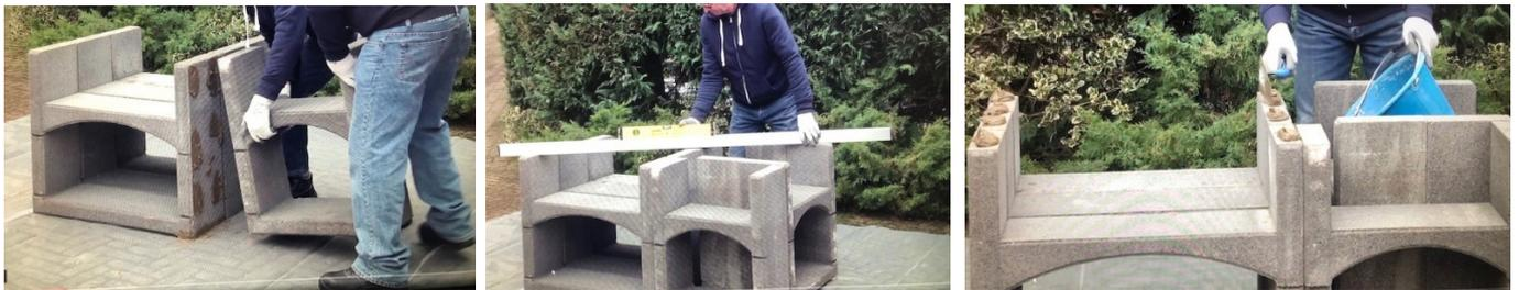
Préparez le mortier et distribuez-le sur l'élément comme ci-dessus, puis mettre le deuxième élément, appliquez le mortier, puis le troisième et ainsi de suite en suivant le schéma du modèle. Ensuite vérifiez si tous les éléments sont bien à niveau.
