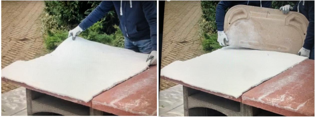
Mettre le matelas de protection sur le plan côté four, puis poser dessus la paroi de fond du four en laissant un espace de 8-10 cm du bord arrière du plan de travail.
