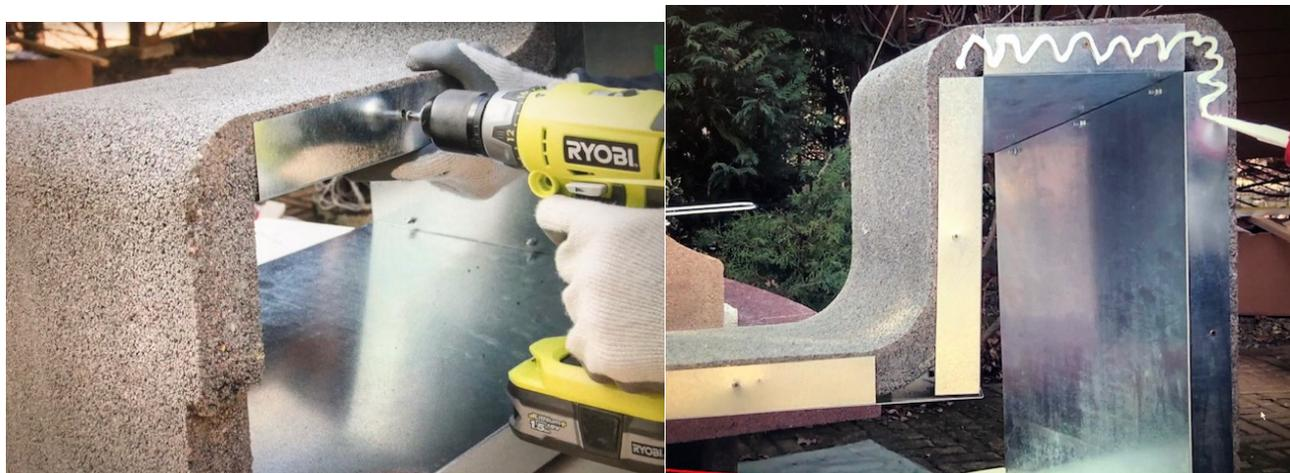
Fixez la hotte de protection en métal sur la hotte en béton et distribuez la colle sur la partie en acier et sur le bord en béton de l'autre côté.
