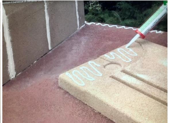
Poussez la colle dans les joints et applatir à l'aide d'une spatule. Commencez à assembler la paroi du barbecue qui sera posée contre le fond du four (voilà pourquoi il fallait laisser 8-10 cm d'espace au fond du plan de travail).
