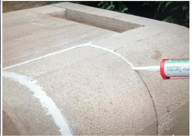
Posez l'élément de couverture du four en laissant l'ouverture pour la sortie de fumée comme photo ci-dessus, puis appliquez la colle Easyfix sur tous les joints.
