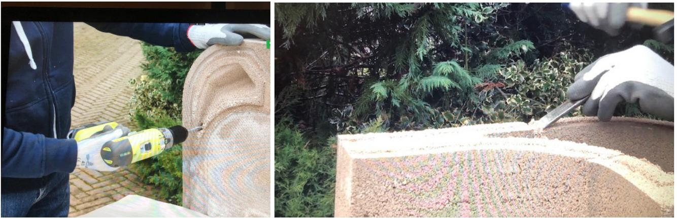
Percez les “pré-trous” qui se trouvent sur les deux côtés de la paroi et utiliser une lime pour nettoyer les rainures où loger les joints.
