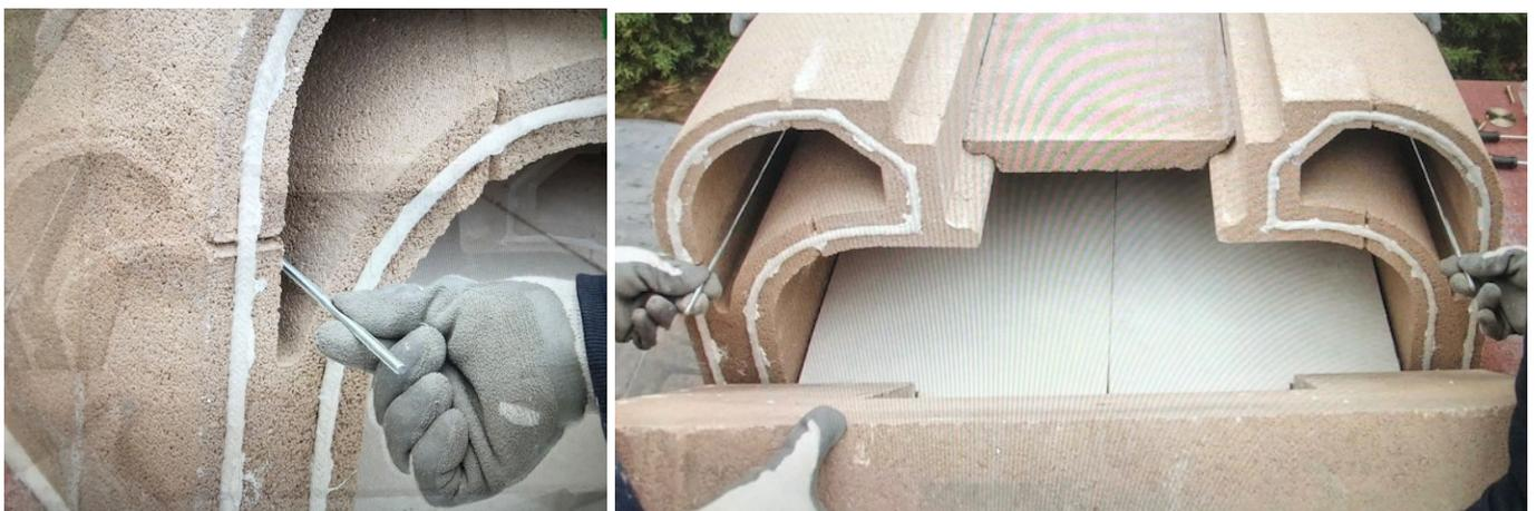
Introduire les tiges en acier dans les trous de la partie arrière et les pousser jusqu'au fond, puis poser la paroi frontale où vous aurez aussi percé les pré-trous et appliqué les joints.
