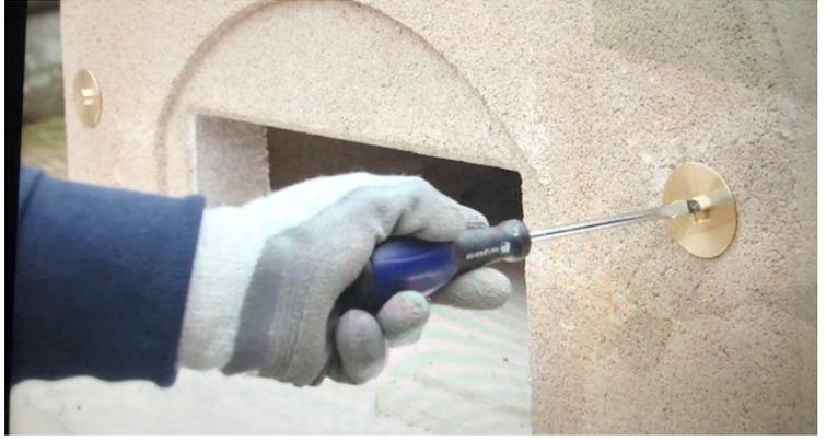
Fermez avec les rondelles et vissez sans trop forcer pour permettre la dilatation des éléments.
