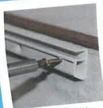
Fixation de la baguette de liner.
