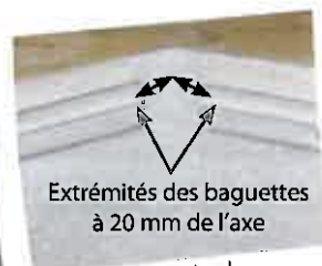
Extrémités des baguettes à 20 mm de l'axe Position de la baguette liner dans les angles
