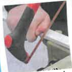
... et découpe de la baguette de liner
