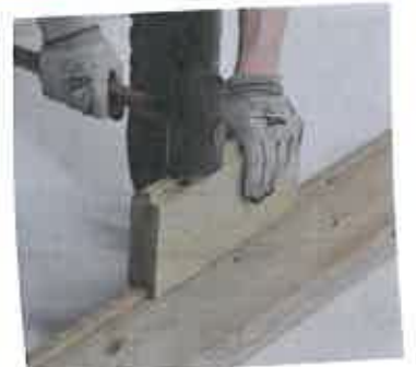
A l'aide d'un maillet, frappez sur la cale en bois pour emboîter à fond le madrier.
