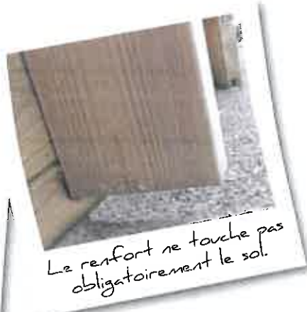
Assemblez le renfort en mettant une vis par madrier.
