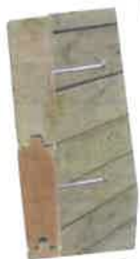
Assemblez le renfort en mettant une vis par madrier.
