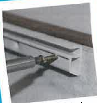
Fixation de la baguette de liner.
