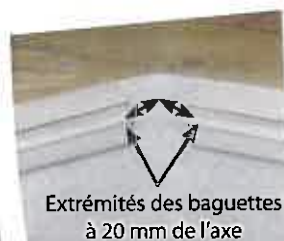
Extrémités des baguettes à 20 mm de l'axe Position de la baguette liner dans les angles
