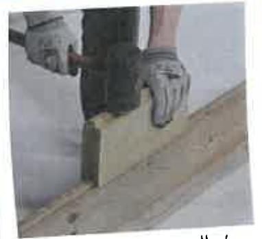
A l'aide d'un maillet, frappez sur la cale en bois pour emboîter à fond le madrier.
