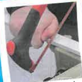
... et découpe de la baguette de liner
