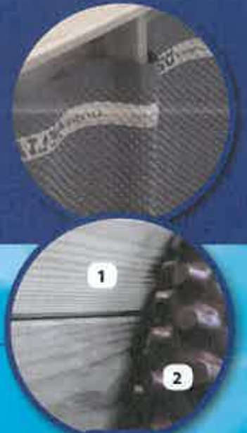
1 - Ossature bois 2 - Rouleau de protection et de drainage alvéolaire en PEHD
