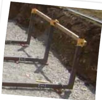
Maintenez l'aplomb des montants verticaux pendant la prise du béton
