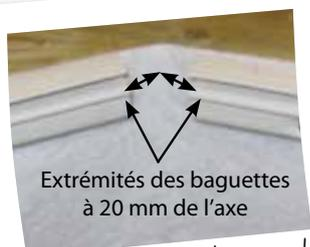
Extrémités des baguettes à 20 mm de l'axe
